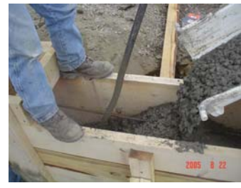
Pouring concrete pipe bent
